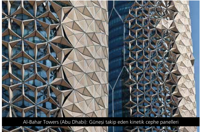
Al-Bahar Towers (Abu Dhabi): Güneşi takip eden kinetik cephe panelleri
